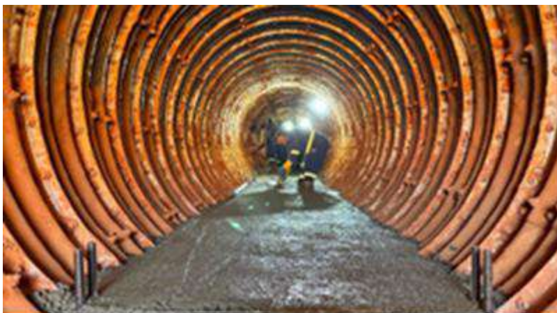
Instalação da Subadutora Gama 111
