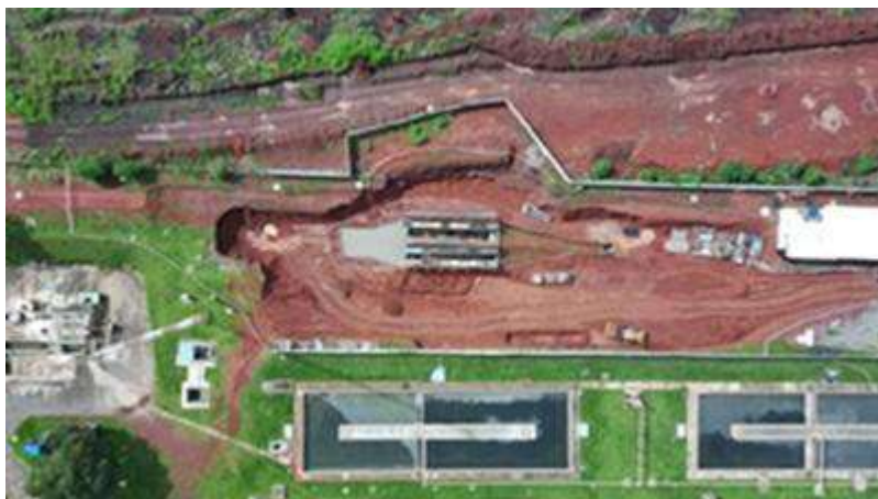
Obra do tratamento preliminar da ETE Paranoá
