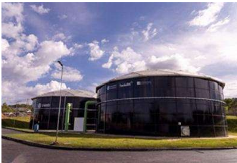
Reservatórios de água tratada do Sistema Paranoá Norte
